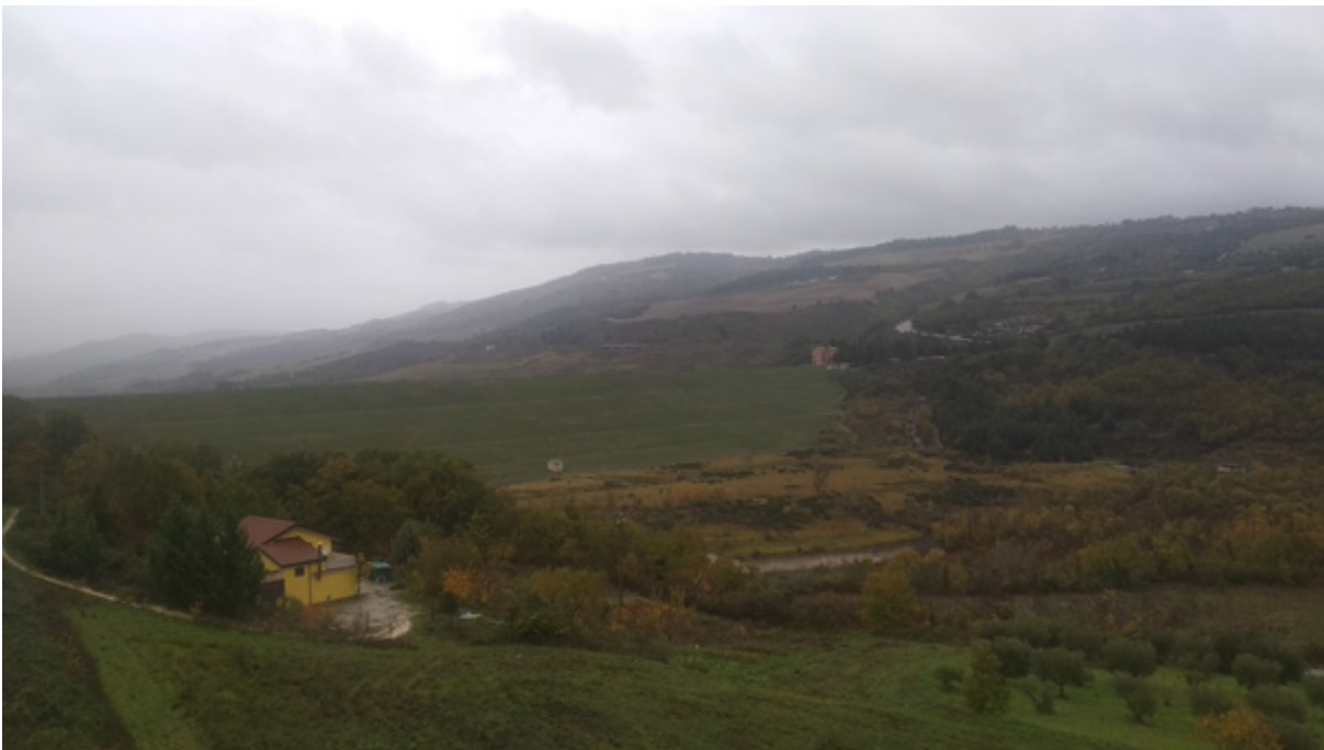
Figura 8.1: Paramento di valle della diga di Genzano.
