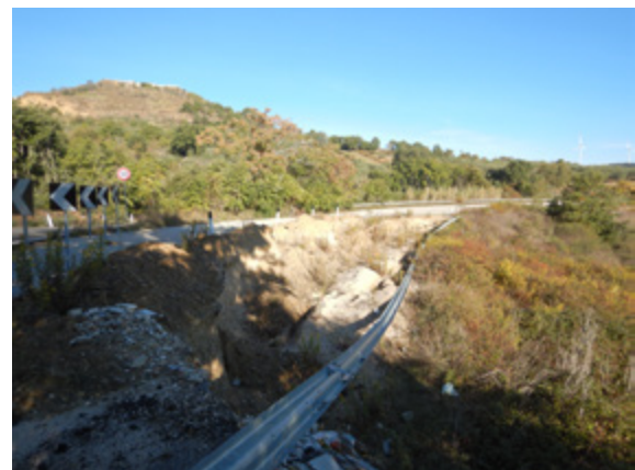
(b) Nicchia di distacco in spalla destra.
