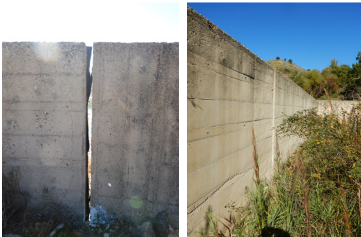
(a) Giunto di dilatazione. Vista frontale.
