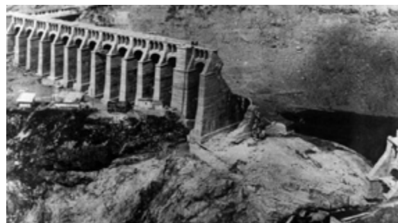
(b) Dissesto lungo il corpo diga.
