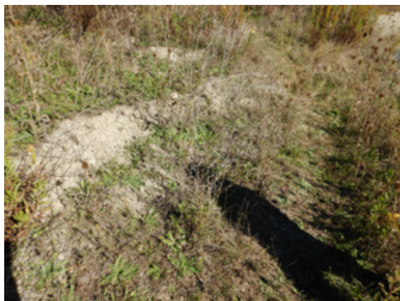
(c) Nicchia di distacco in sponda sinistra.
