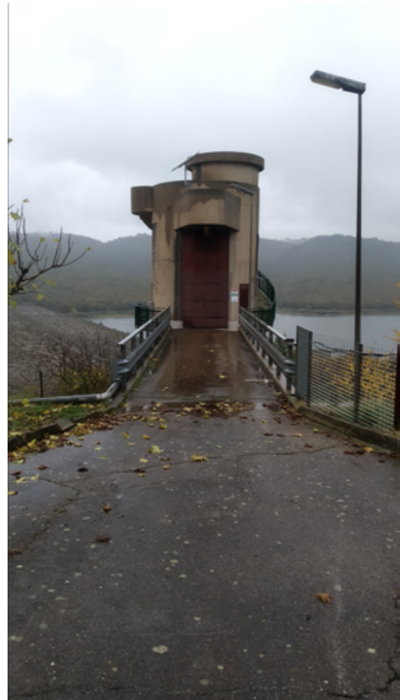
(b) Pozzo di accesso alla camera di manovra diga di Genzano.
