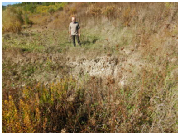
(a) Nicchia di distacco in sponda destra.
