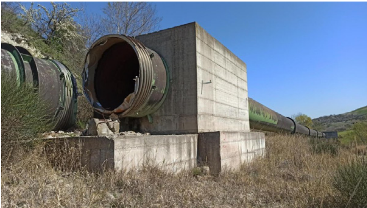
Figura 8.4: Paramento di valle della diga di Genzano.
