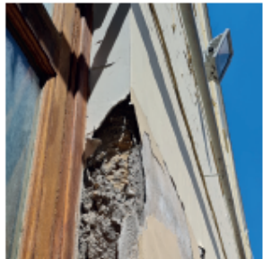
Muratura portante in blocchi di tufo
