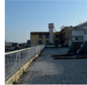
Solaio di copertura in laterocemento
