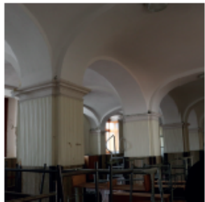
Volte a vela in blocchi di tufo
