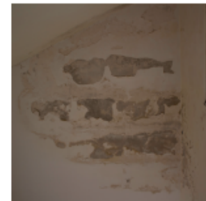
Solai intermedi su putrelle
